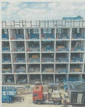
Bouwvakkers aan het werk bij een nieuwbouwproject. FOTO ANP
